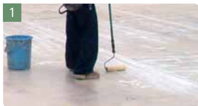
プライマー塗布
