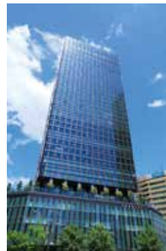
大名古屋ビルヂング
